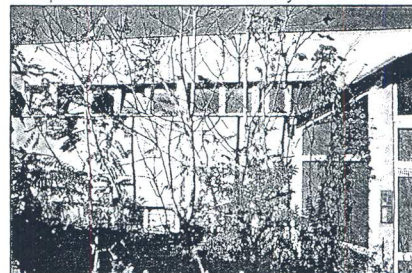
časť fasády prízemí zo strany ulice
