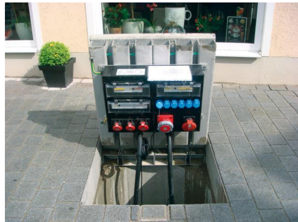
Obr.: Vzorové riešenie podzemnej rozvodnej skrine (www.gifas.de)
