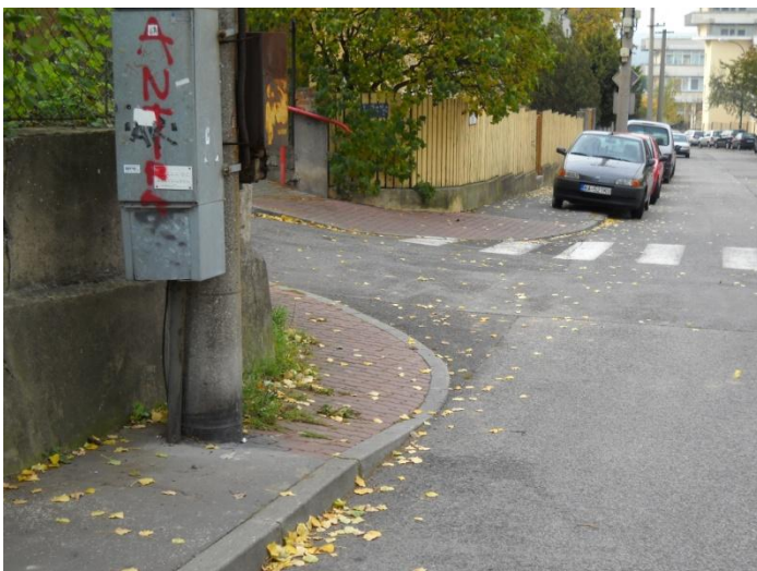
obr.: Typický príklad umiestnenia verejného technického vybavenia v križovatke ulíc Jakubíkova a Jahodová, limituje pešiu dopravu.
