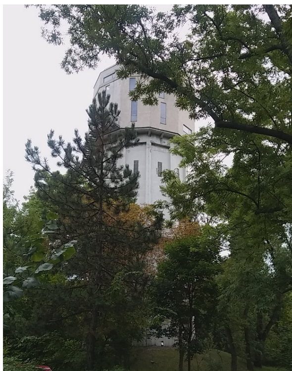
Obrázok 14 Budova bývalého vodojemu v Parku Nobelova
