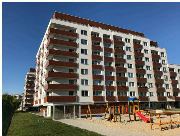
Obrázok 5 Nové bytové domy Nobelova – východný pohľad
