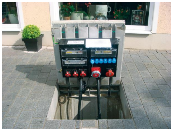
Obr.: Vzorové riešenie podzemnej rozvodnej skrine (www.gifas.de)
