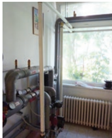
Nové rozvody ústredného kúrenia v jaslách na Robotníckej ulici
