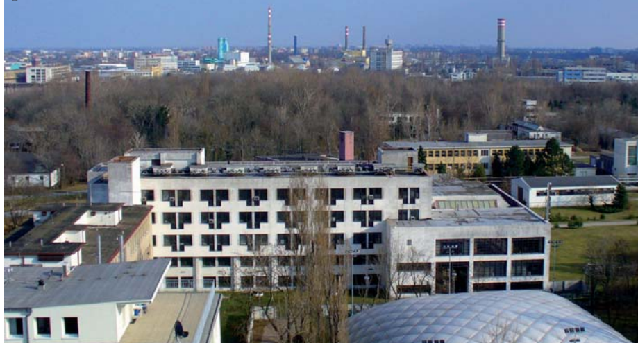
Pohľad na budovu Výskumného ústavu chemickej technológie (dnes VUCHT, a.s.), v pozadí vpravo Závod mieru, vľavo Paroplynový cyklus ZSE, lesný porast ukrýva prevádzku trhavín (2012)
